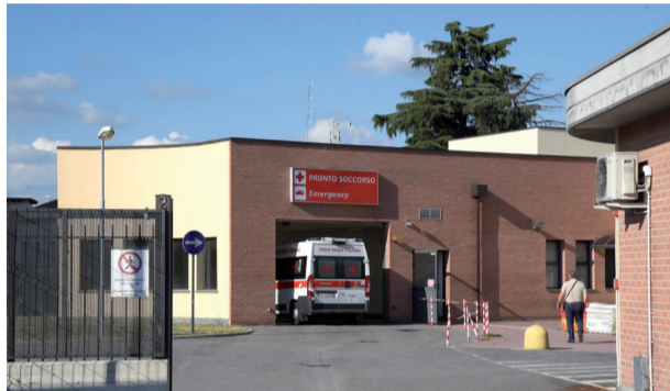
Il Pronto soccorso dell'ospedale sarà ampliato e sopraelevato
